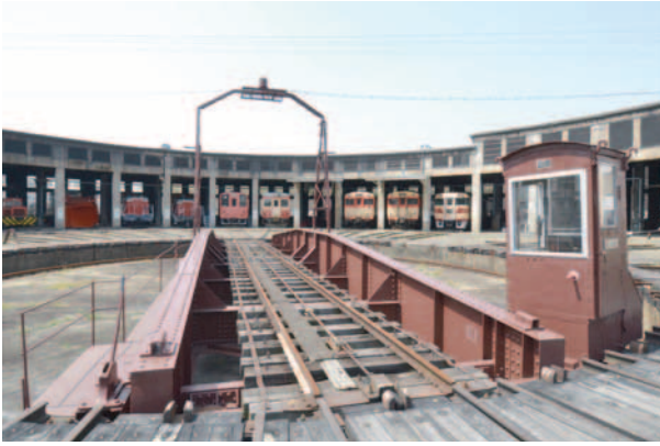
▲旧津山扇形機関車庫
